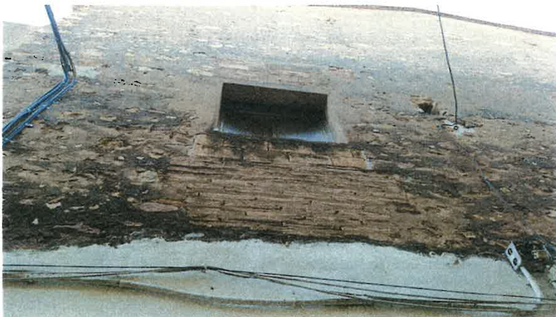
Parte de las ventanas tapiadas del Carrer Estret
